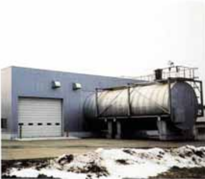
バイオガスプラント全景 (中温域による処理)
