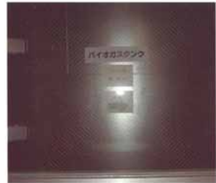
脱流したバイオガスを貯留するタンク
