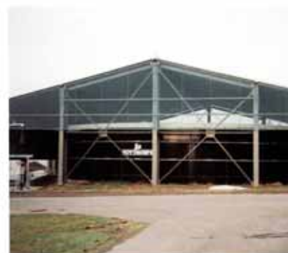
7ヶ月分の消化液を貯留するスラリース トアー (2100m 3 )
