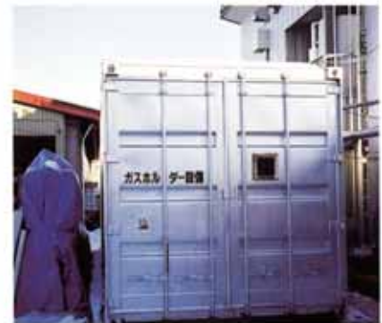
バイオガスを貯留するガスホルダー (中古コンテナを利用している)
