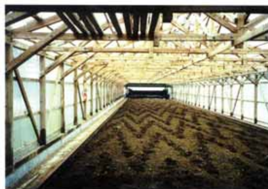
木造でポリカ張りの発酵舎内部
