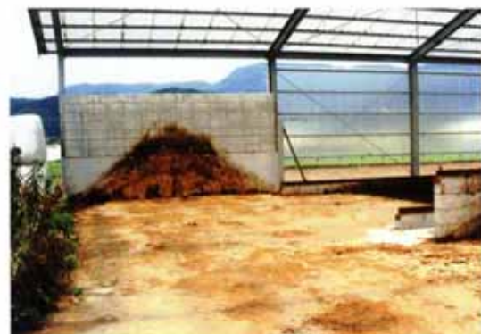
投入時の水分を調整する為の側壁
