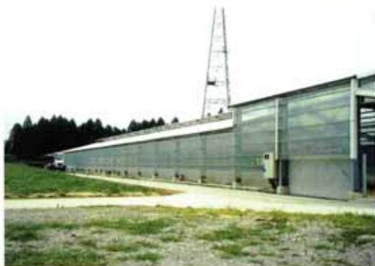
堆肥舎全景（壁にもポリカーボネート板を使用）
