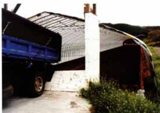
パイプハウスで造った非常に低コストな乾燥舎（専用ダンプで投入している）
