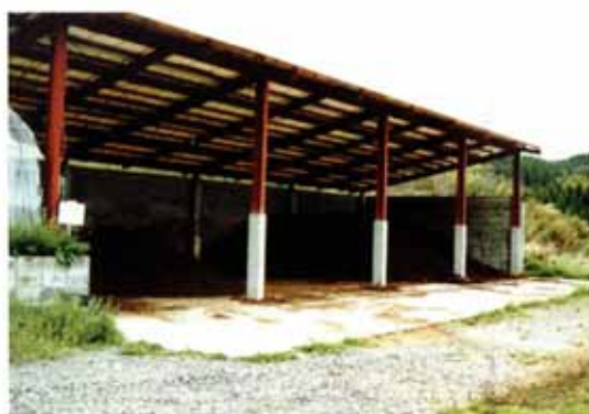
堆肥舎の全景
