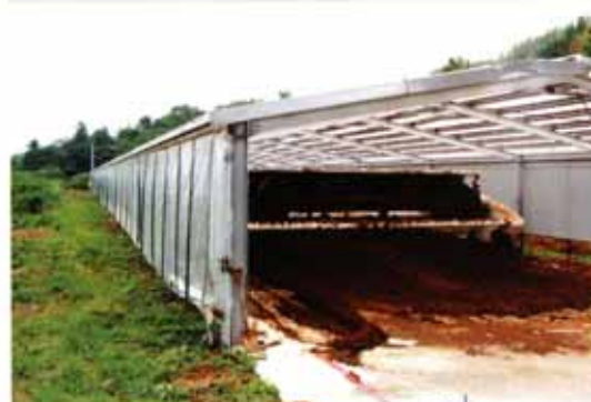
側壁にはビニールカーテンを使用
