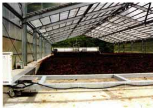
発酵舎内部（槽の深さ30cm）
