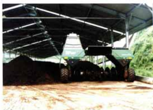
堆肥舎内部と自走式の攪拌機
