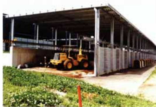
発酵槽（クレーン式攪拌）の全景
