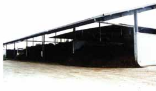
堆積式発酵堆肥舎の全景
