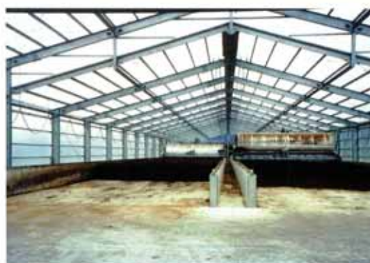
攪拌発酵槽内部（投入口）
