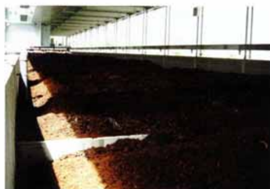
発酵槽の内部
